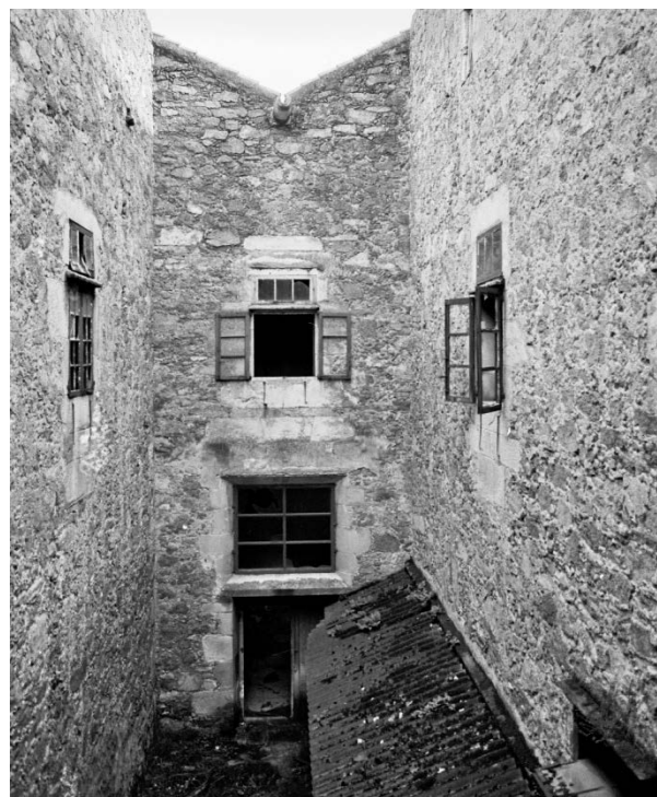
4. Patio interior del edificio
