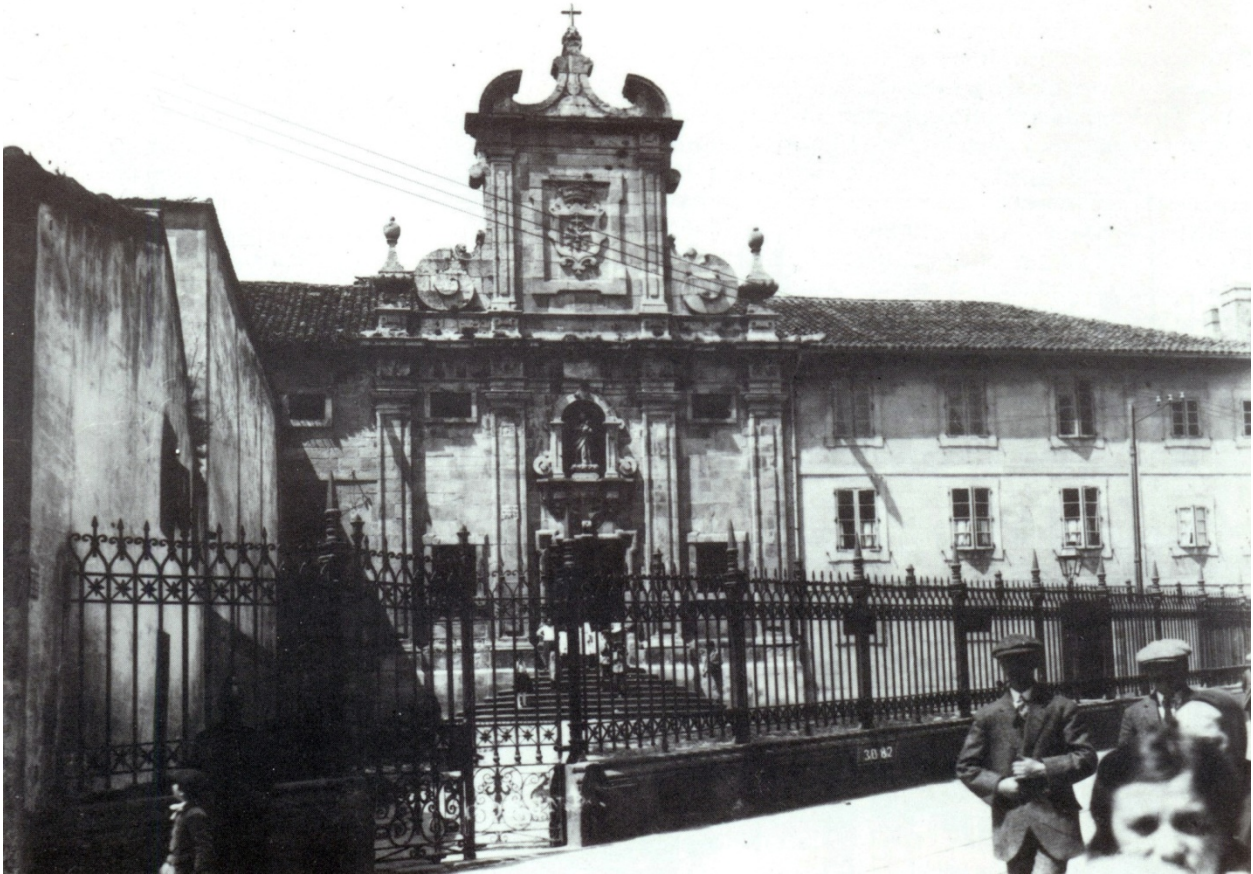
2. Portada de la iglesia conventual y muro de la huerta ya desaparecido, 1950
