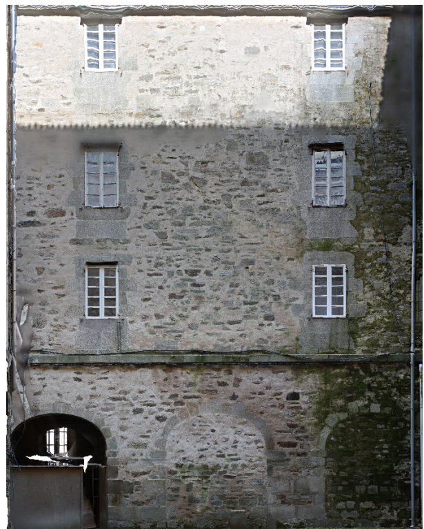
4. Fachada Sur Patio de los Cerdos. Fotogrametría
