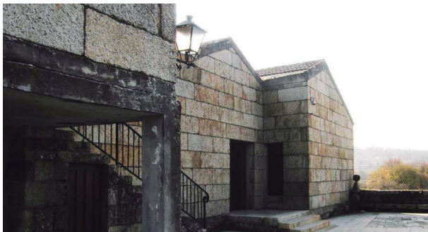
12. Imágenes de la iglesia construída
