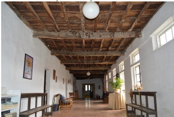
6. Planta primera. Pasillo de la casa rectoral
