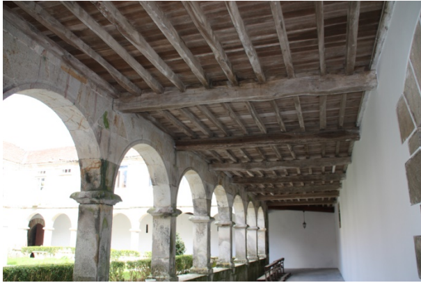
5. Planta baja. Claustro perimetral del edificio
