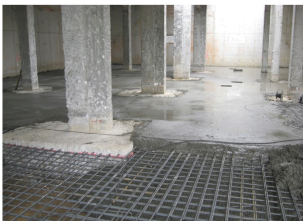
9. Secuencia de recuperación de la cimentación
