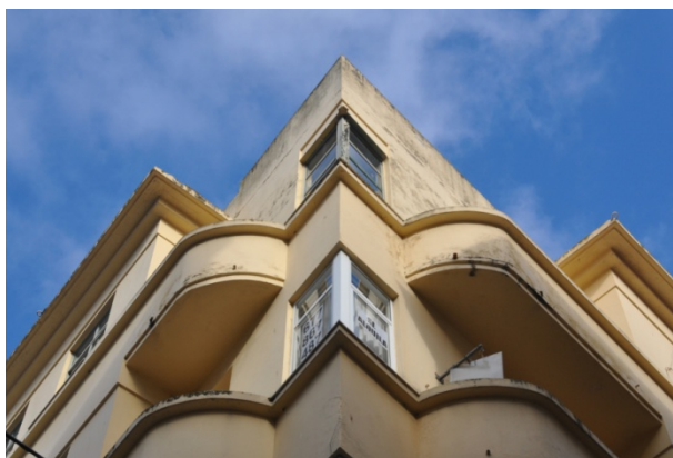
10. c/Torreiro, 6-8. Arq. Tenreiro-Estellés, 1933
