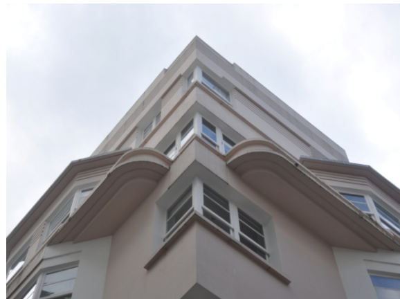
6. Casa de Bernardo González c/Estrella, 36. Arq.Tenreiro-Estellés, 1936
