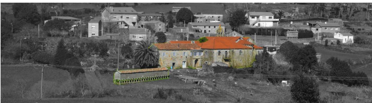
3. Vista general del conjunto y hórreo desde el frente Este
