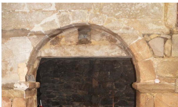
14. Reapertura de un arco que había sido tapiado con mampostería en una época anterior
