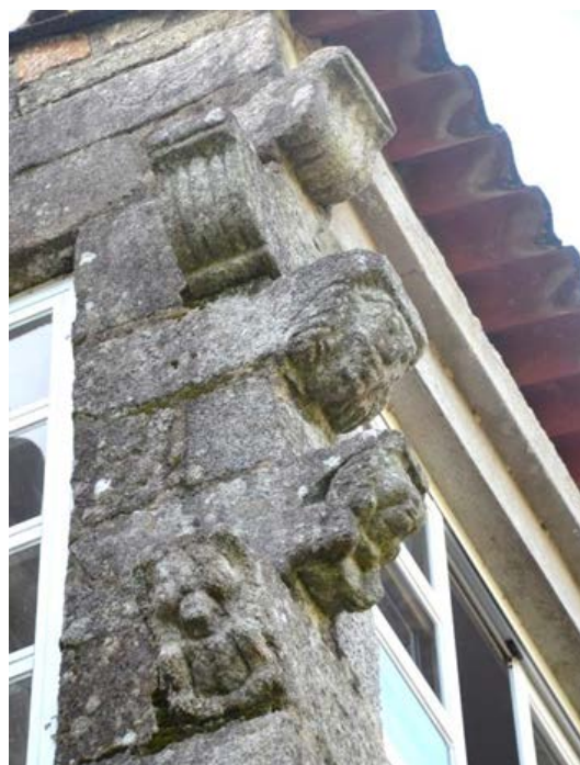
13. Disposición de los canes de la sala capitular en el vértice del balcón-solario Este
