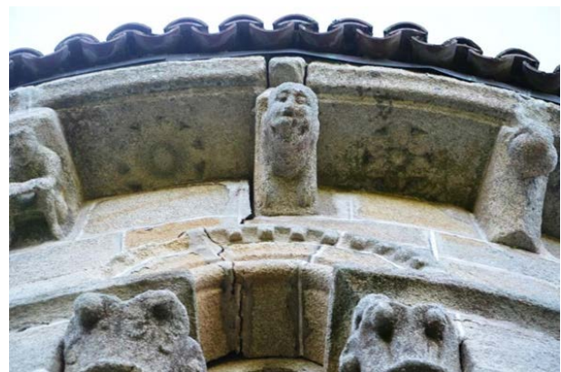
6. Detalle de los canecillos y dos rosetas esculpidas en el alero del ábside central
