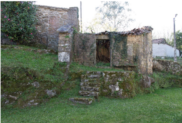
10. Construción auxiliar do cemiterio
