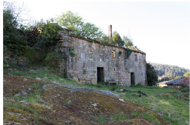
7. Fachada principal da casa reitoral co pombal anexo
