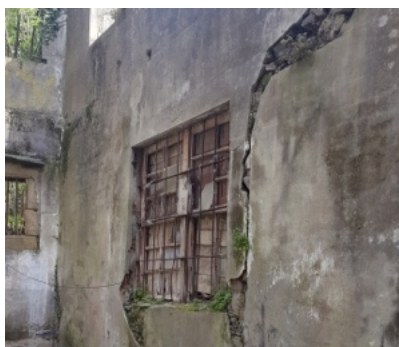
4. Imagen del hormigón
